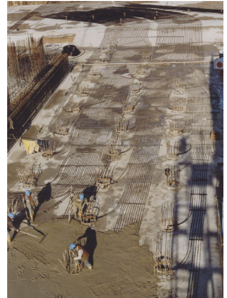
Bild 3: Verlegung von Zuleitungen zu den Energiepfählen
