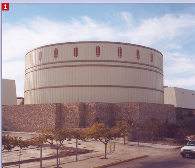
1 University of Texas, El Paso (1999), 15 100 m 3 Kaltwassertank mit gleichzeitiger Funktion als Löschwasserreserve, Quelle: John S. Andrepont, Coolsolutions und Chicago Bridge & Iron Co.
